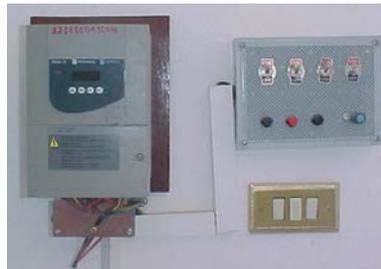
Figure 1 : Variateur de vitesse du moteur électrique et système de commande
