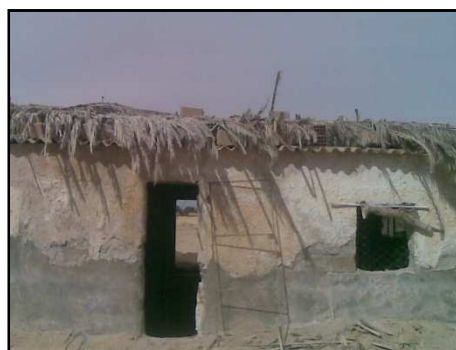
Fig. 1 . Murs enduits de chaux
