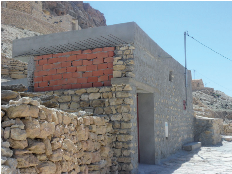
Figure 6. Photo d'une nouvelle maison construite (Nos photos, 2014)
